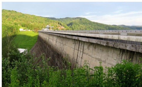
Zdjęcie 42. Zapora Solińska – betonowy kolos w krajobrazie Bieszczadów
