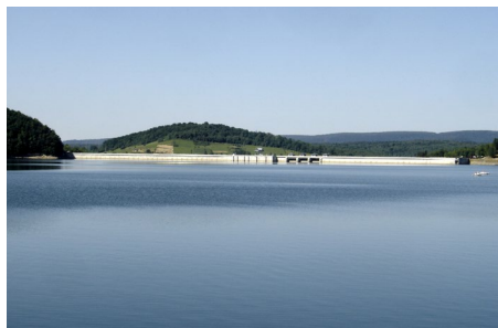
Zdjęcie 41. Jezioro Solińskie; w głębi widoczna zapora
