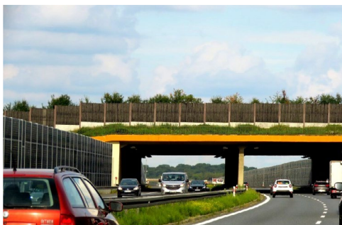
Zdjęcie 46. Przejście górne nad autostradą dla dużych zwierząt
